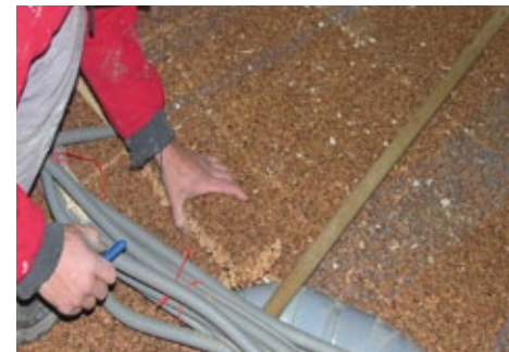
Isolation de plancher avec du liège
