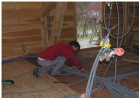
Isolation de plancher avec du liège
