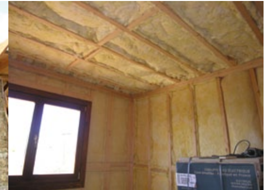
Isolation murs et plafond
